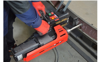
Bohren außerhalb der Position
