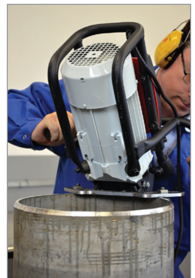
Fasen von Rohren
